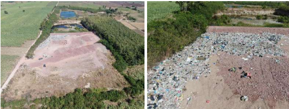
รูปที่ 5 ภาพถ่ายมุมสูงของสถานที่กำจัดขยะมูลฝอยองค์การบริหารส่วนตำบลวังเพลิง และพื้นที่โดยรอบ โดยอากาศยานไร้คนขับ (โดรน)
