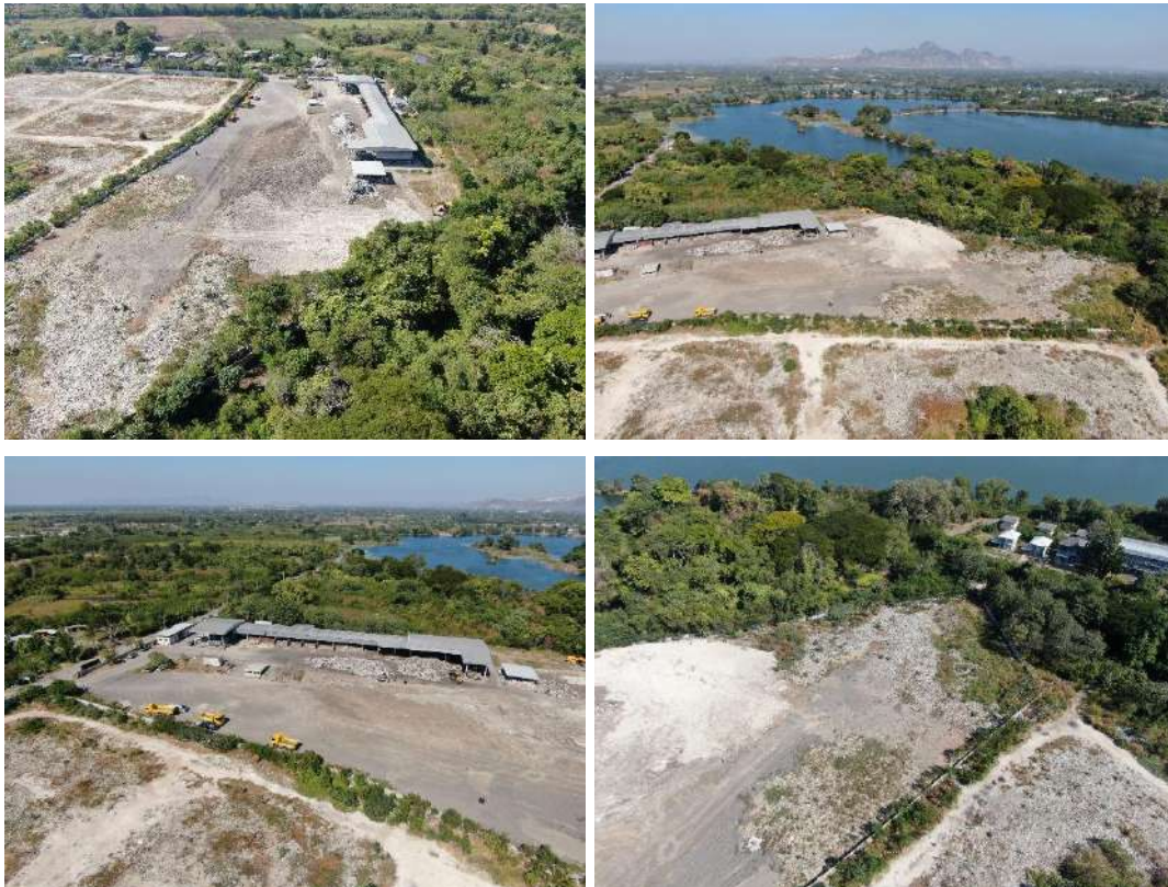
รูปที่ 5 ภาพถ่ายมุมสูงของสถานที่กำจัดขยะมูลฝอยองค์การบริหารส่วนจังหวัดสระบุรี และพื้นที่โดยรอบ โดยอากาศยานไร้คนขับ (โดรน)
